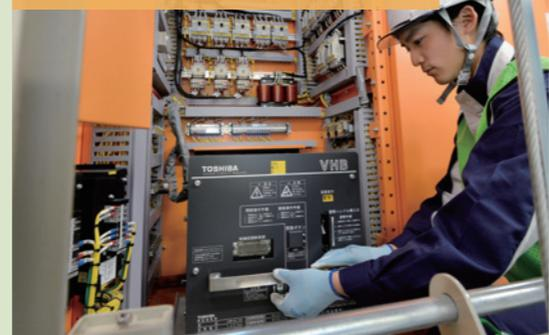
受電方式に合わせた停復電操作や、遮断器・ブレーカ交換作業の研修を行います。また、漏電発生装置による漏電回路調査の研修も行います。
